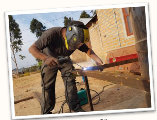
Wassertank Sicherung schweißen
